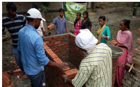
फोटो-8 वर्मी कम्पोस्ट का पिट निर्माण
