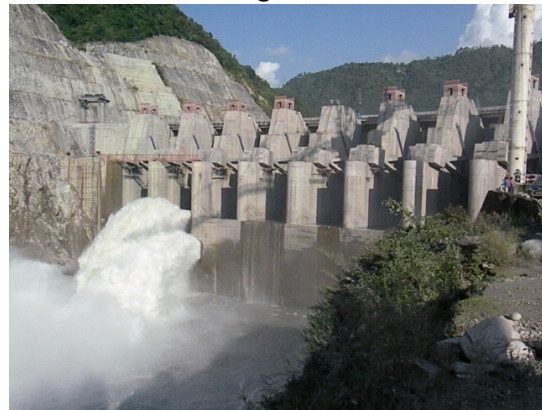
Vishnuprayag Barrage Site
